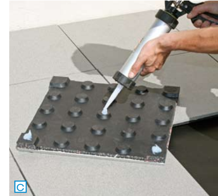
C Wenn eine Platte zu tief liegt, wird auf die entsprechenden Noppen Silikon aufgebracht.
