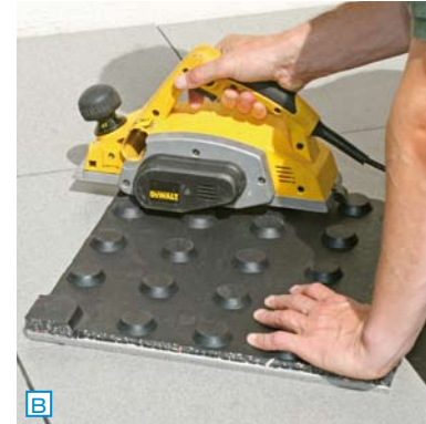
B Wenn eine Platte zu hoch liegt, werden die entsprechenden Noppen mit einem Elektrohobel abgehobelt.
